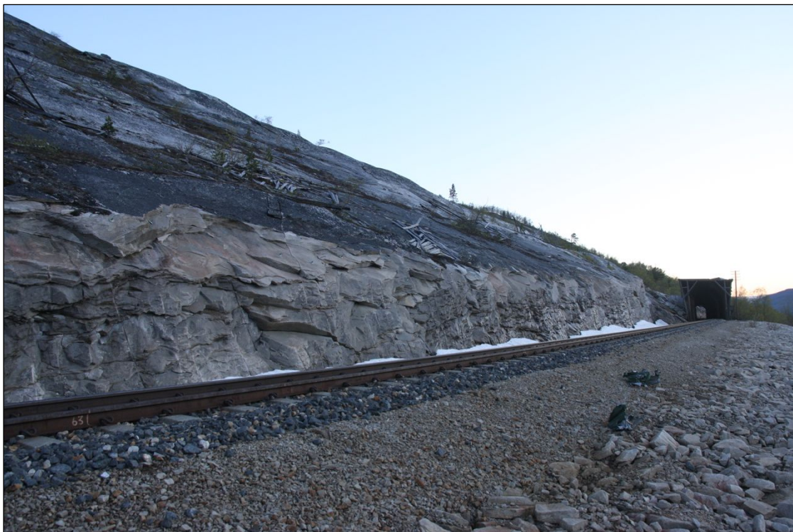
Figur 10. Nordlandsbanen ved Viskisoverbygget. Skjæringen i fjellet og rester av vindskjermene er synlige inngrep som kan ses på lang avstand. Foto: Ingve Birkeland.
