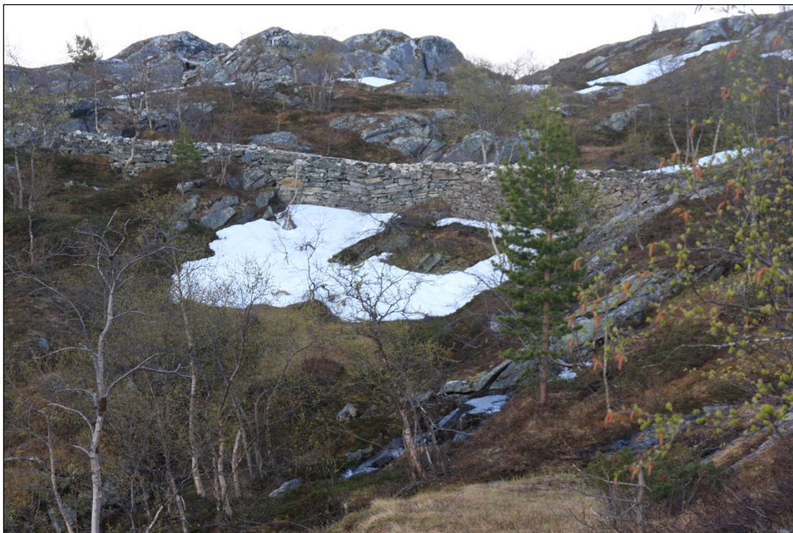
Figur 13. Den gamle anleggsveien ovenfor Viskis. Foto Ingve Birkeland
